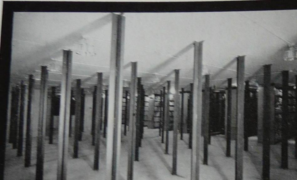
Poteaux d'ossature d'un encombrement pratiquement nul, supportant la dalle de béton armé constituant les planchers.
